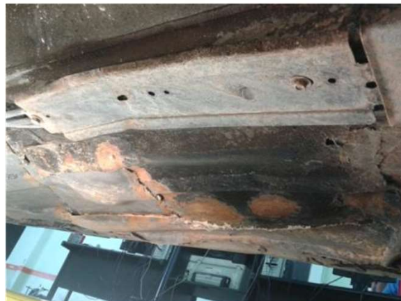
Assoalho com reparos inadequados e corrosões excessivas.
