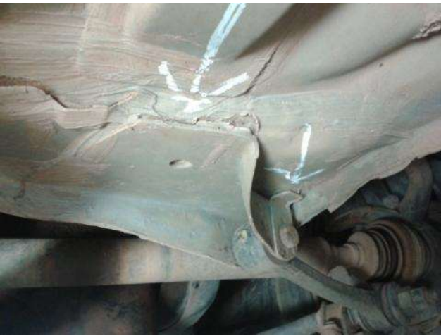
Descravamento do suporte de fixação do braço oscilante.
