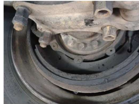
Ausência do espelho do tambor de freio. Má fixação do eixo.
