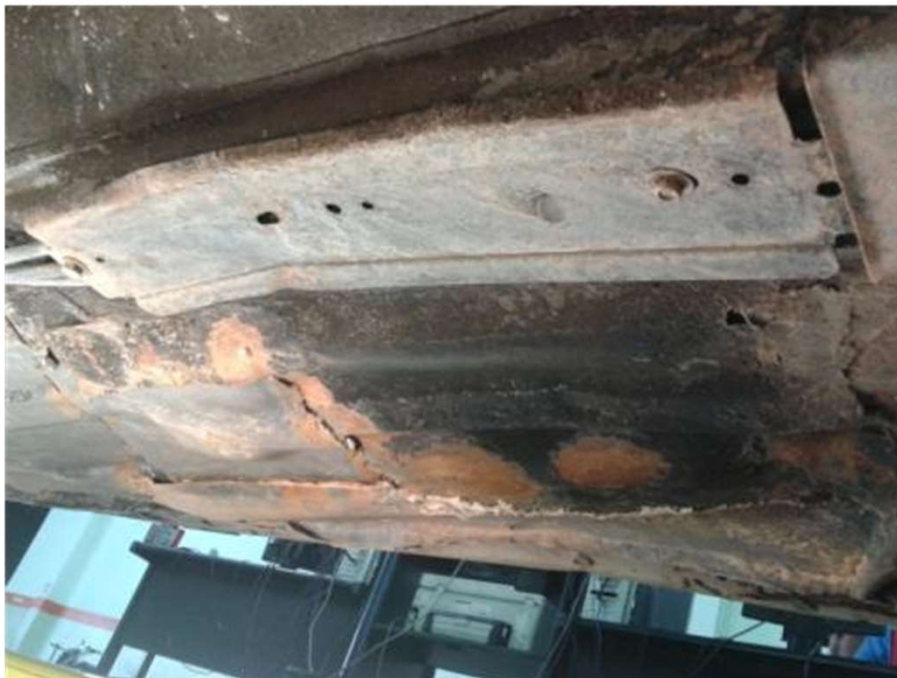
Assoalho com reparos inadequados e corrosões excessivas.
